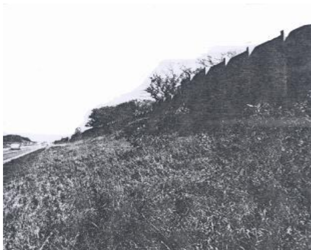
شکل ۳: نمونه‌ای از یک مانع صوتی چوبی در حاشیه یک آزادراه.
